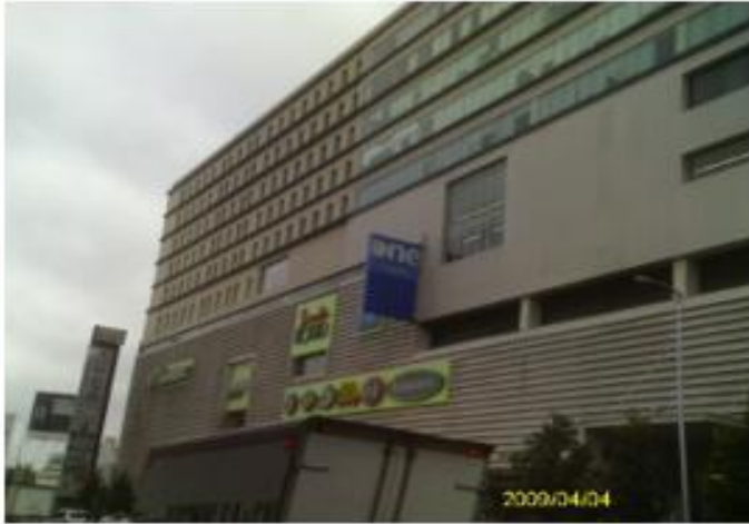
PLAZA COMERCIAL: MANTENIMIENTO, FACHADA DE CEMPANEL CDMX
