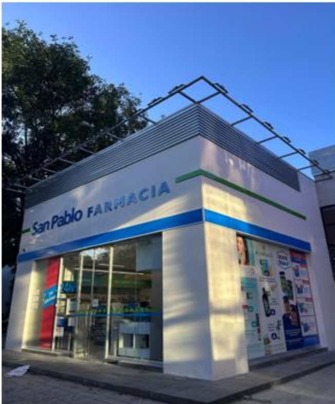
FARMACIA SAN PABLO: FACHADAS CEMPANEL RECTIFICADO MIGUEL HIDALGO, CDMX
