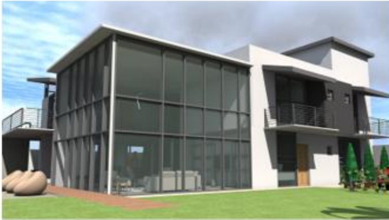
CASA HABITACION: DISEÑO, INGENIERIA Y CONSTRUCCION, EN PROCESO ATLATLAHUCAN MORELOS
